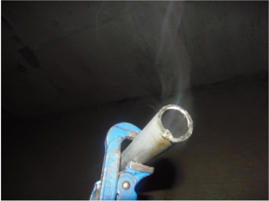
Фото. Район Академический. Трубопровод центрального отопления- следы коррозии отсутствуют т.к. вода предварительно подготовлена. не коррозионно активна.
