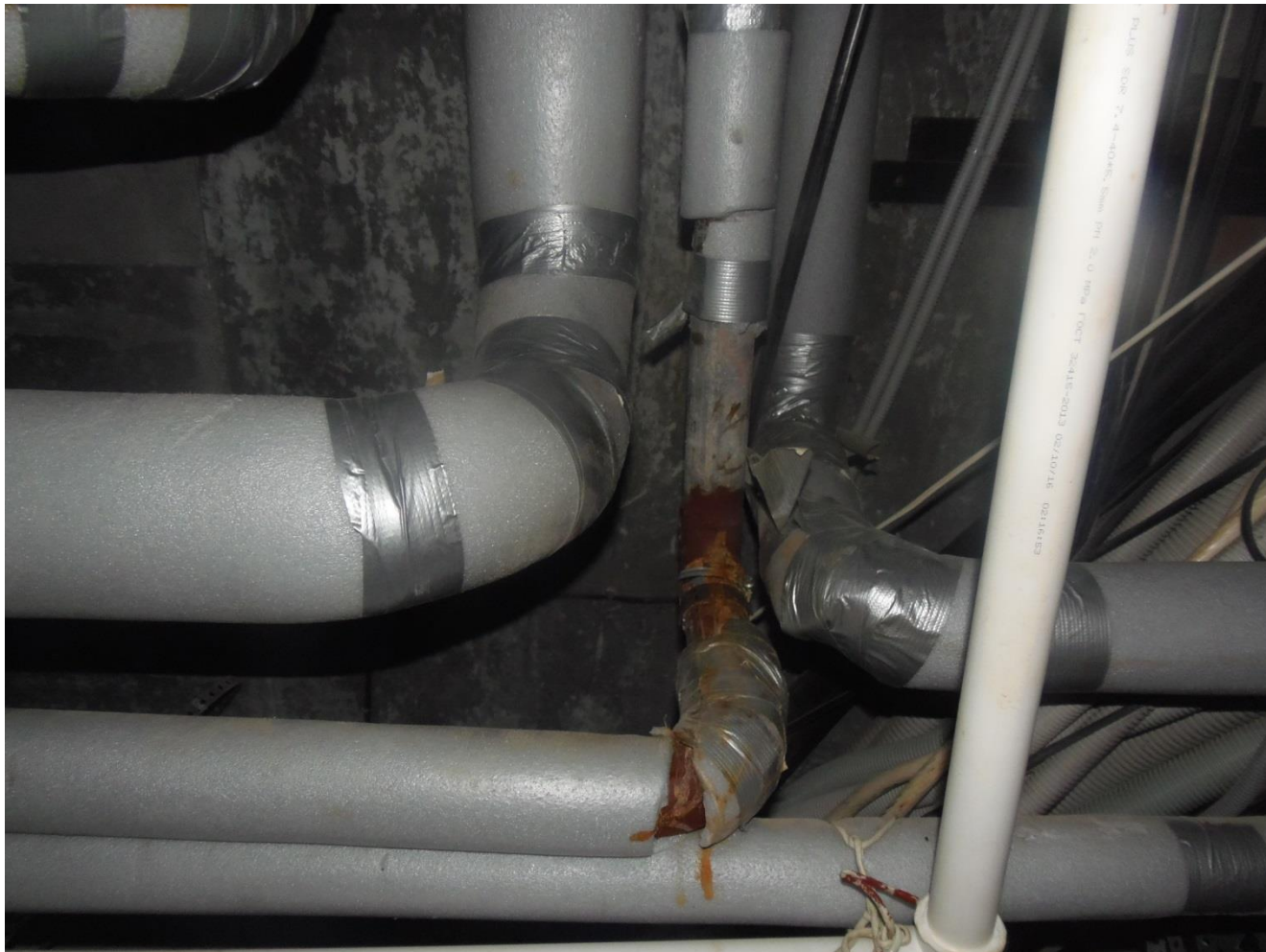
Фото. Следы коррозии.
