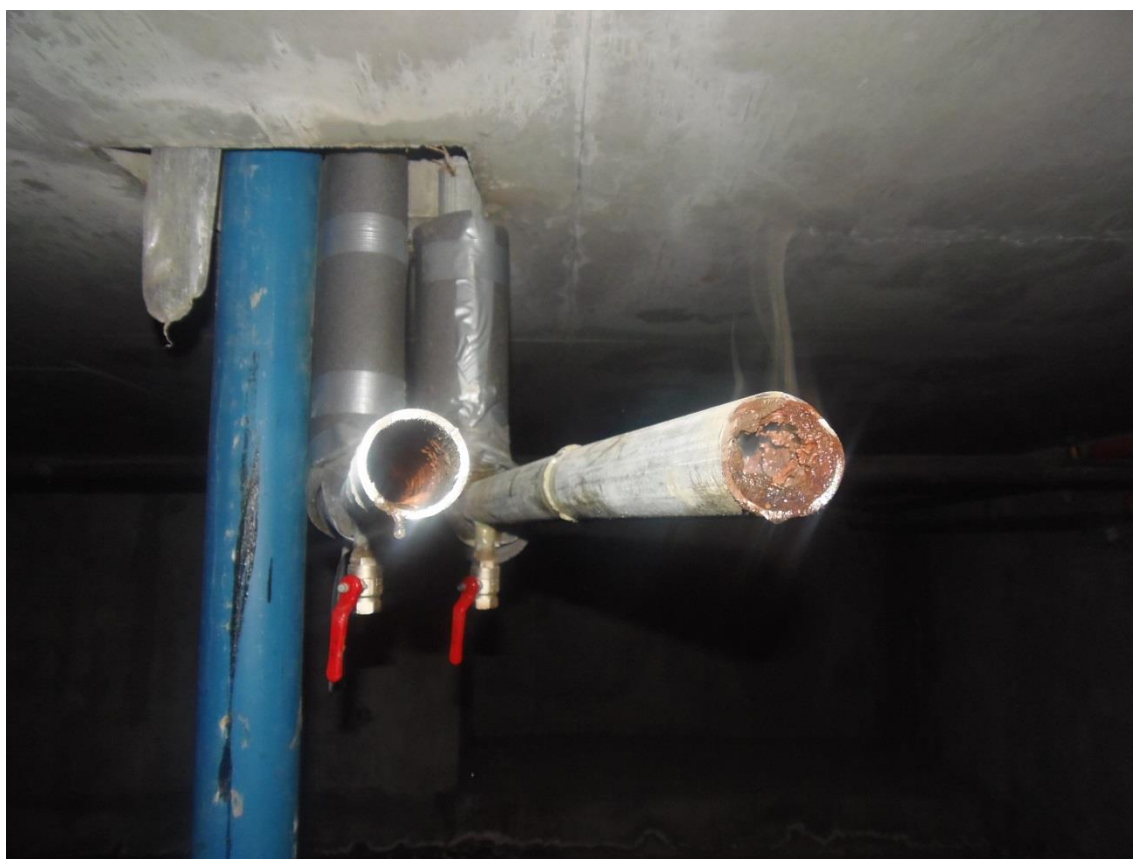
Фото. Район Академический. Слева трубопровод холодного водоснабжения, справа- горячего.
